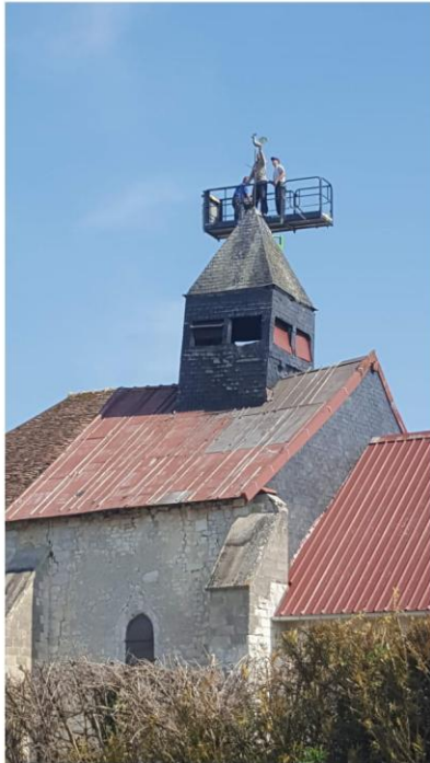
Figure 3: Dépose du coq le 23 avril 2021
